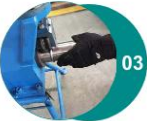
Use AQUApipe lugging machine to lug the pipe.
